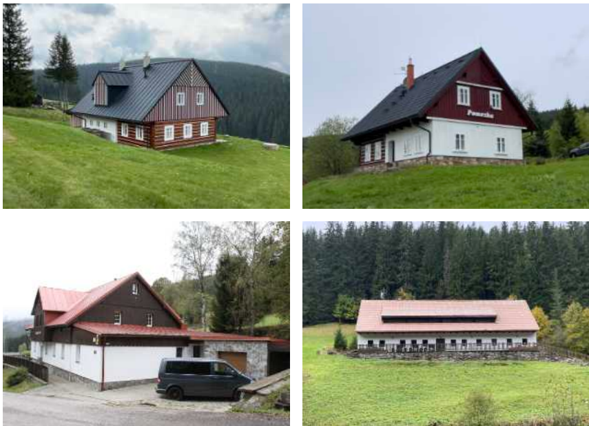
Provádění omítaných stěn u replik typu 1 a 2 je zcela nevhodné, viz ev. č. 5 DMÚ a ev. č. 1 HMÚ, u typů 4 jde pak o výskyt negativní (např. ev. č. 123) a je žádoucí jeho redukce, nikoliv rozšiřování (viz čp. 26 DMÚ).
