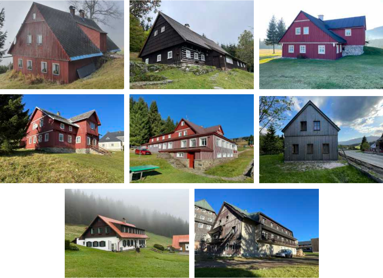
Vertikální deštění je nejtypičtější ukázkou povrchu štěn chalup, a také lomenic (zde neuvedeny jako samostatný atribut). Starší podoba čp.101 DMÚ či čp. 95 HMÚ, případně rekonstruované čp. 60 HMÚ. U staveb typu 2 pak čp. 68 DMÚ a čp. 91 DMÚ. U současných příkladů zejm. čp. 115 HMÚ. Mezi negativními příklady lze zmínit čp. 78 HMÚ či čp. 113 HMÚ.
