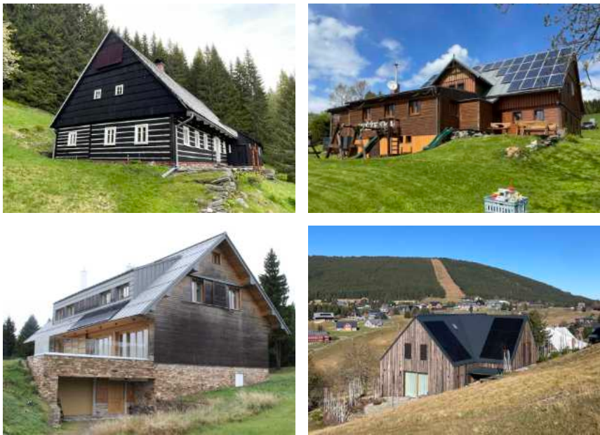
Negativní je jak umístění na fasádu, např. na štít, viz čp. 27 DMÚ, a stejně tak umístění na střeše, viz čp. 82 DMÚ a ev. č. 7 HMÚ. Akceptovatelné je umístění směrem ke svahu, ideálně co nejblíže u lesa, aby nebyla střecha patrná v dálkových pohledech, viz ev. č. 12 HMÚ.
