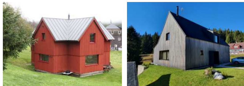
Příklady typu 5: e. č. 13 Horní Malá Úpa, čp. 138 Dolní Malá Úpa
