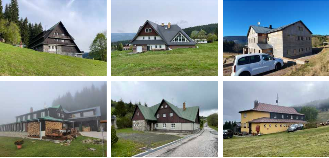
Následující příklady dokumentují především negativní projevy střešních sklonů a nevhodných návazností střešních rovin: jde jak o střechy příliš strmé, viz čp. 111 DMÚ a 128 HMÚ, či naopak střechy se sklonem mírným, viz čp. 113 DMÚ. Zcela negativní jsou složité kombinace střešních rovin bez přirozené konstrukční návaznosti, viz čp. 102 DMÚ, či čp.29 nebo 92 HMÚ.
