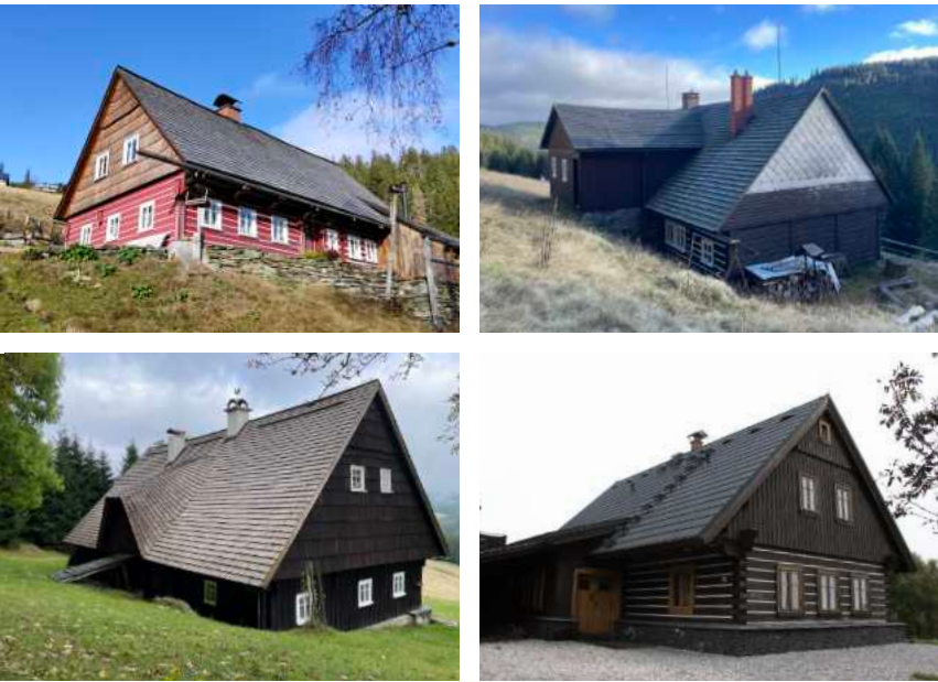
Štípaný šindel je vedle malolúpského seníkového vikýře nejcharakterističtější atributem místní lidové architektury. Za pozitivní příklady platí např. čp. 31 a čp. 33 DMÚ, případně čp. 95 HMÚ. Plastový šindel je akceptovatelnou náhradou, viz čp. 140 HMÚ.
