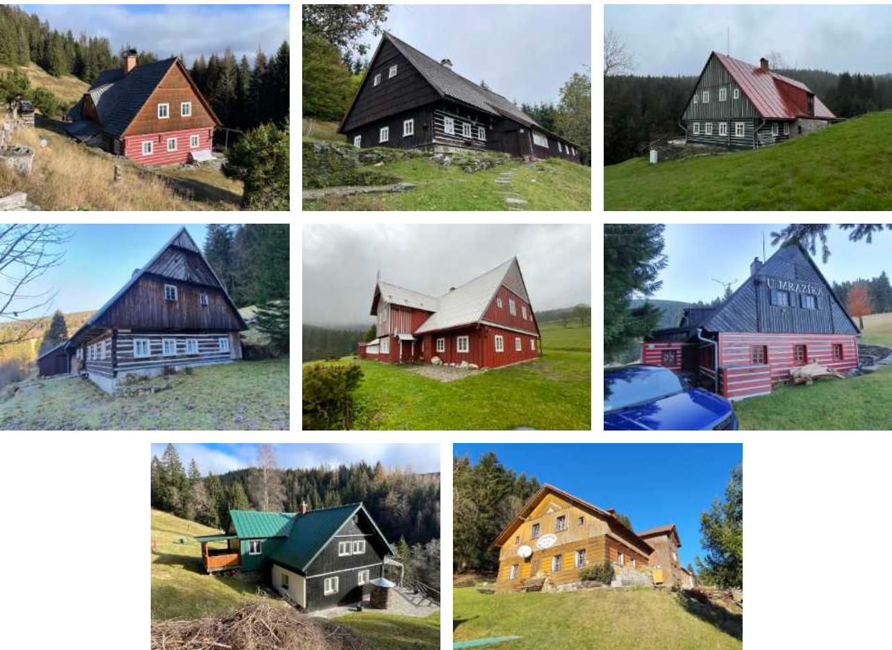
Mezi dobré příklady šindelových střech patří např. čp. 31 DMÚ a čp. 95 HMÚ, svislé deštění např. čp. 80 HMÚ, s lomenicí např. čp. 109 DMÚ či čp 76 HMÚ a další. Negativním projevem deštění štítu je jak nevhodná lomenice, viz např. čp. 79 HMÚ, tak deštění palubkami, viz čp. 1 DMÚ či čp. 46 DMÚ.
