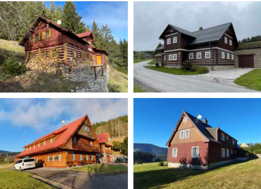
Jako dobré příklady originálního přesahu je možné zmínit čp. 16 DMÚ, případně renovované čp. 33 HMÚ. Naopak negativními případy jsou čp. 107 a čp. 125 DMÚ.
