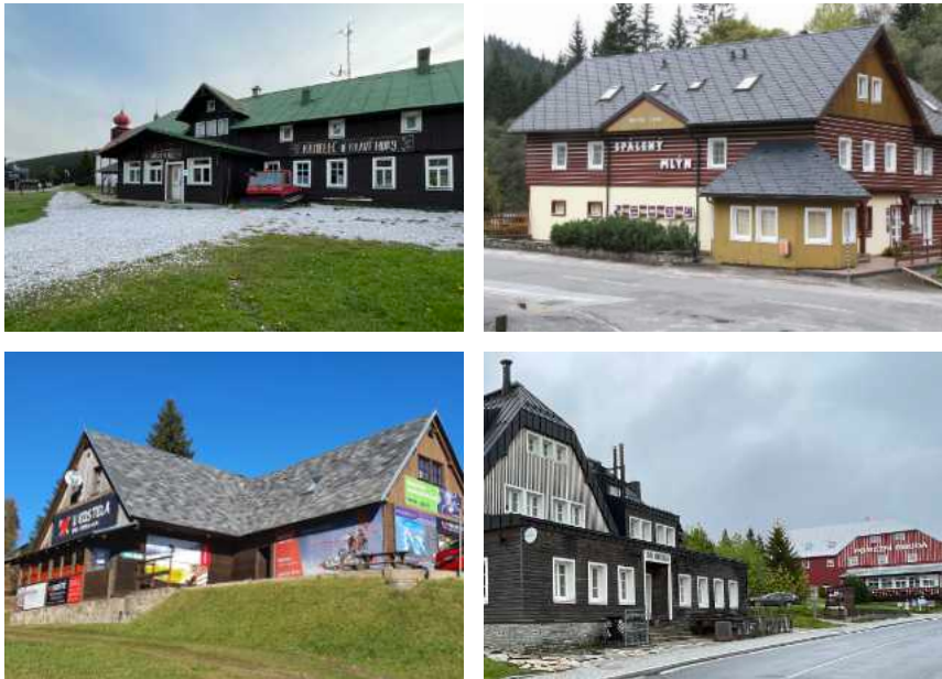
Negativním příkladem jsou bannery na čp. 72 DMÚ, či poutače na čp. 120 DMÚ, zcela odstrašujícím případem je čp. 131 DMÚ. Za pozitivní lze považovat například označení na čp. 41 HMÚ, v pozadí naopak již nevhodně dominantní popis chalupy na čp. 40 HMÚ.
