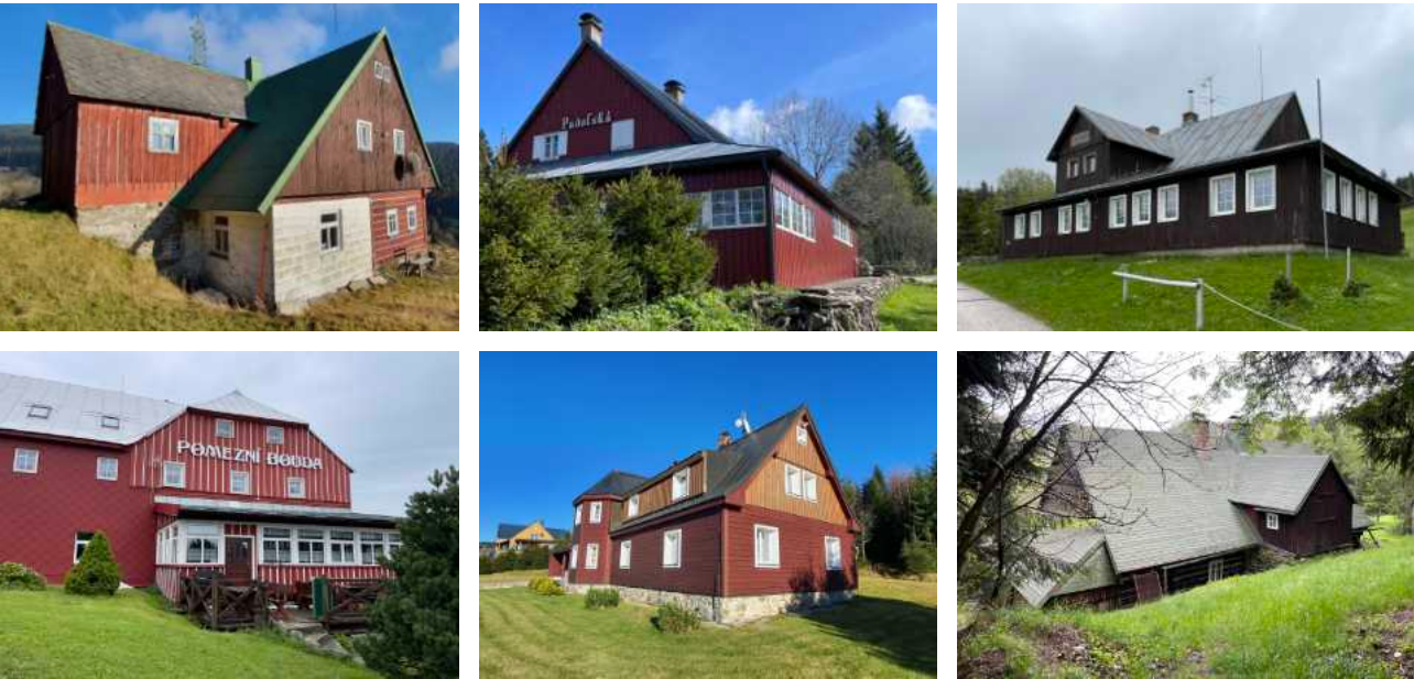
Příkladem obložení z umělého kamene např. čp. 54 DMÚ, nevhodné plechové deštění čp. 69 HMÚ, příklady plastových oken čp. 37 a čp. 40 HMÚ, falešného roubení např. čp. 125 DMÚ, šindelové střechy pak asfaltový šindel v nevhodné proporci čp. 3 DMÚ.
