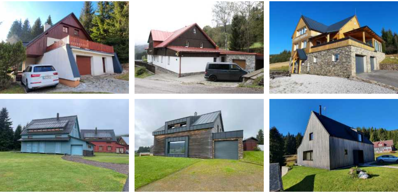
V současné zástavbě Malé Úpy neexistuje pozitivní příklad samostatného objektu garáže. Mezi negativními lze zmínit přístavby k domům, např. 65 či čp. 123 DMÚ, zcela problematický je objem čp. 137 DMÚ. Nežádoucí jsou ale i adice u menších novostaveb, jako při čp. 133 či čp. 146 HMÚ. Jedním z výjimečně solidních příkladů je u čp. 138 DMÚ integrace do hmoty domu.
