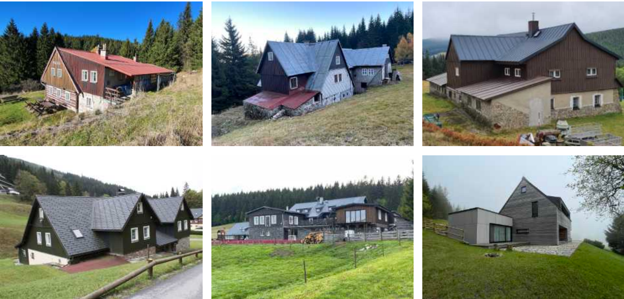
Zatímco některé přístavby lze v čase vnímat již jako „domestikované,“ neboť jsou více než 100 let staré a architekturu specificky kontextuálně rozšířily (viz čp. 74 HMÚ), ve většině případů jsou přístavby drastické. Za všechny např. čp. 83 a čp. 92 HMÚ či o něco mladší přístavba čp. 24 DMÚ či přístavby k čp. 114 DMÚ. U současných staveb adice jako u ev. č. 5 HMÚ
