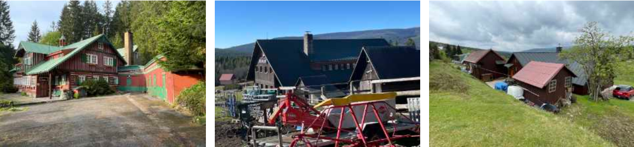
Jako středně problematické lze chápat v jedné linii vybudované hospodářské stavby při čp. 21 či 79 DMÚ, jako výhradně problematické lze vnímat například objekty okolo čp. 30 HMÚ.
